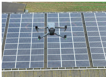
Statt aufs Dach zu steigen, inspiziert Marc Göhlich PV-Anlagen per Drohne.
